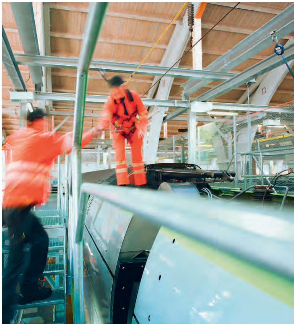
BLS-Mitarbeitende bei Instandhaltungsarbeiten
