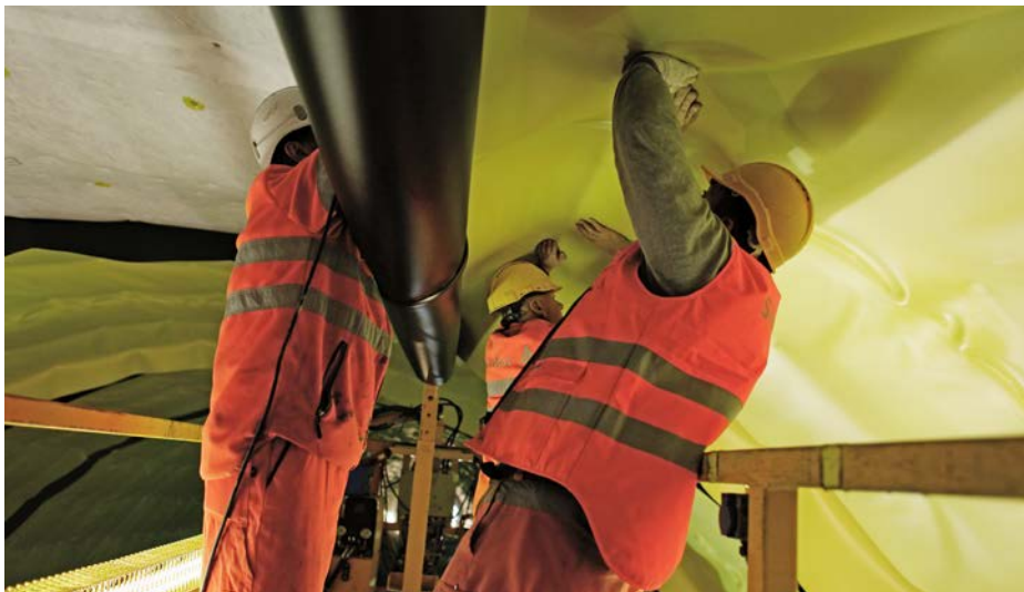
Die Abdichtungsfolie wird auf dem Spritzbeton befestigt.
