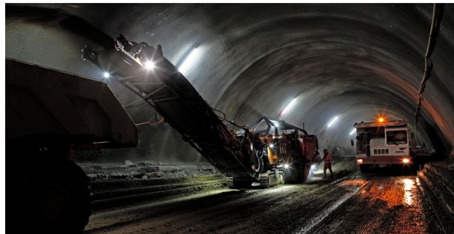
Das gefräste Material wird auf Dumper geladen. Im Viertelstundentakt bringen die Tunneldumper Material aus dem Tunnel in die nahegelegene Grube Mädersforst.
