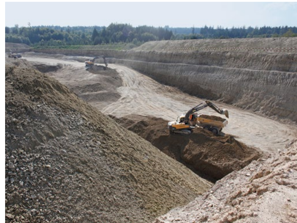
Abbau und Auffüllen. In der Erweiterung Süd wird Wandkies abgebaut, diese wird gleichzeitig seit September mit Material aus dem Tunnel wieder aufgefüllt.
