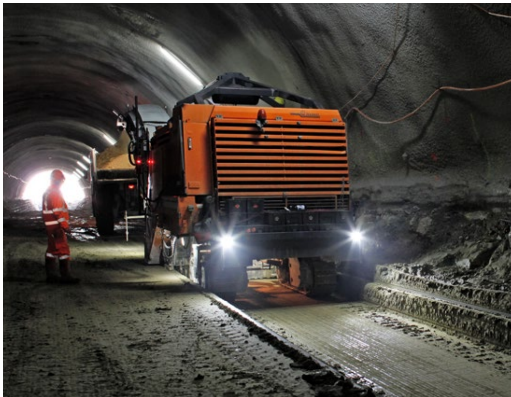
Auf einer Länge von rund 100m fährt die Belagsfräse in Bahnen hin und her. Je Durchfahrt frisst sie sich bis 30cm tief in den Sandstein hinein.
