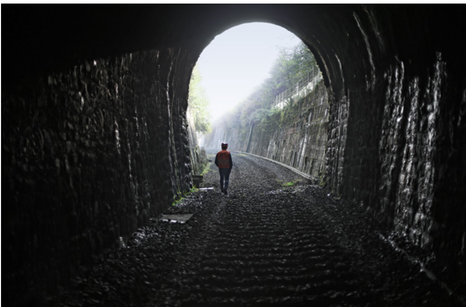
Ausgedient? Als Bahntunnel ja. Doch als Entwässerungstollen erhält der alte Tunnel eine neue Funktion.
