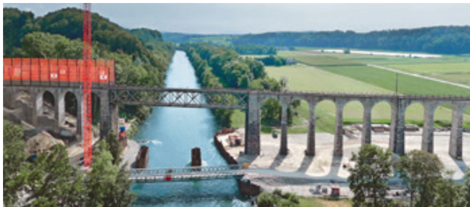
Vorbereitungsarbeiten am Saaneviadukt: Maussviadukt mit Schutzgerüst, Stahlfachwerkbrücke und Hilfsbrücke über die Saane und Installationsplätze beim Gümmenenviadukt (v.l.n.r.)
