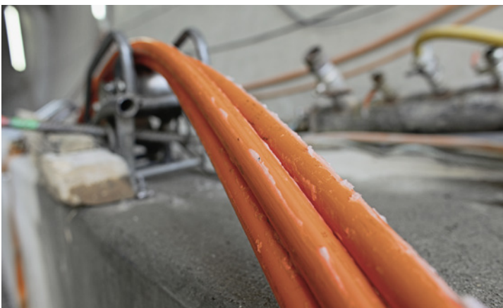
Die Energiekabel werden in die seitlichen Bankette des Tunnels eingezogen.
