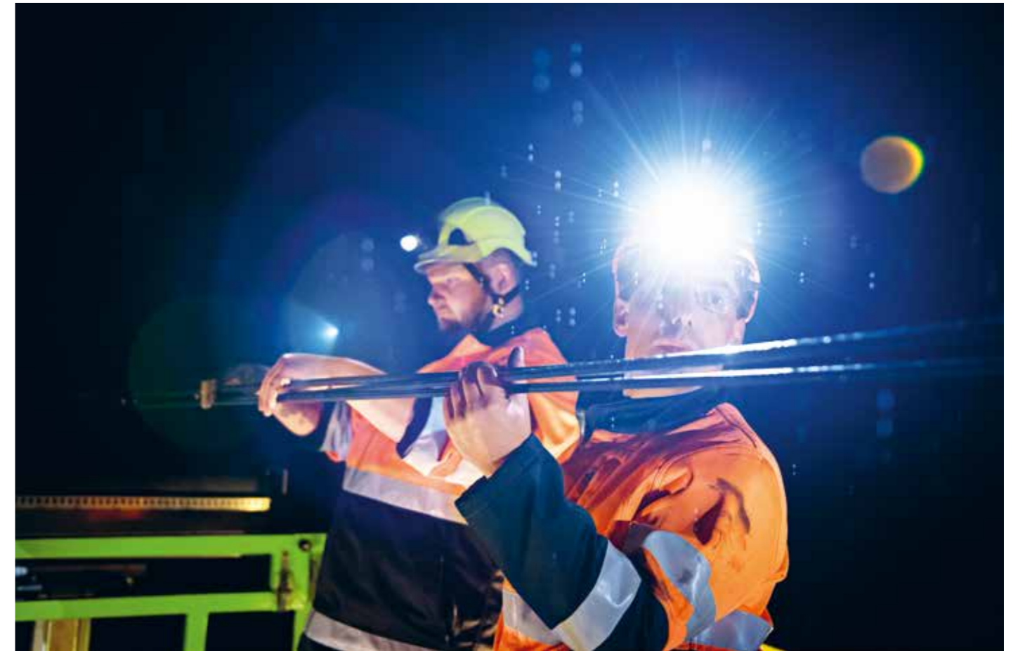
Georg (vorne) und Kevin justieren einen Kreuzungsstab, der zwei kreuzende Fahrdrähte stabilisieren soll.
