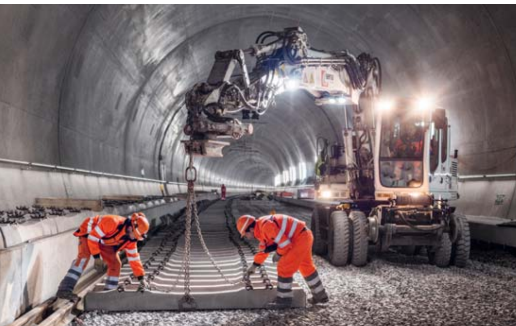
Die Fahrbahn wird in den neuen Rosshäuserntunnel eingebaut.
