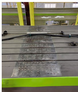
Reparatur eines Wagendachs
