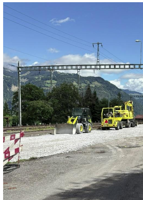
Vorbereitungen zum Start der Bauarbeiten am Bahnhof Leissigen
