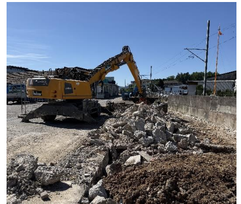
Rückbauarbeiten entlang des Gleises
