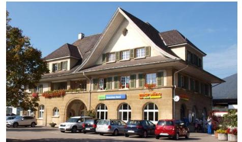
Bahnhofgebäude Grenchen Nord
