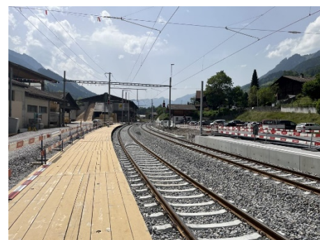
Provisorisches Perron 2 / neues Perron 1
