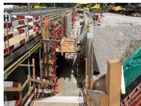
Neubau Rampe Perron 2
