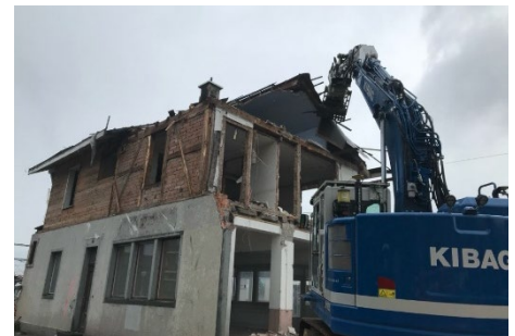
Rückbau des Bahnhofsgebäudes
