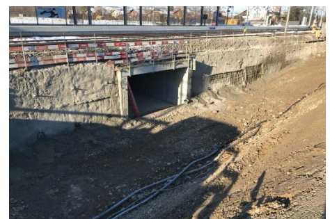
Aushub für den späteren Zugang zur Personenunterführung
