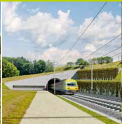
Damit sich das Westportal (Seite Mauss) möglichst gut ins Landschaftsbild einfügt, folgt die Portalwand dem Terrainverlauf. Die grosse Stützmauer rechts davon wird begrünt.
