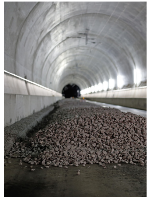
Die erste Schotterdecke liegt bereit.
