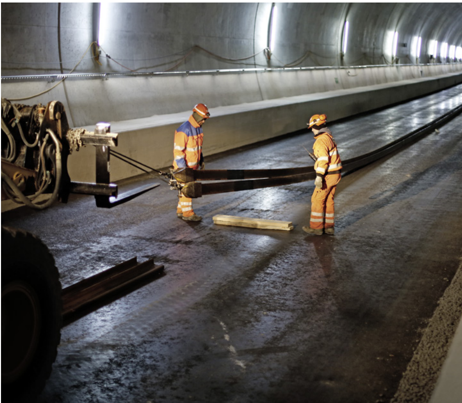
Die Schienenstücke werden in Position gebracht.
