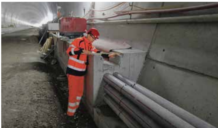
Die Bankette – hier werden im Rahmen des bahntechnischen Ausbaus Kabel für die Stromversorgung und Steuerung eingezogen.
