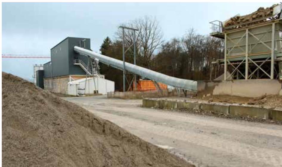
Das Kies- und Betonwerk wird im Herbst abgebaut und der Boden für die landwirtschaftliche Nutzung wiederhergestellt.
