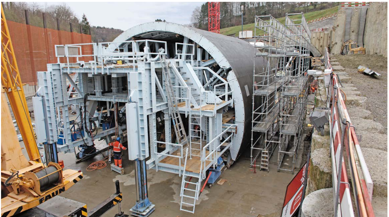
Nach Bohrgeräten und Belagsfräse kommt nun der sogenannte Schalwagen zum Einsatz. Mit ihm werden zuerst der Tagbautunnel West und dann das Tunnelgewölbe mit Beton erstellt.
