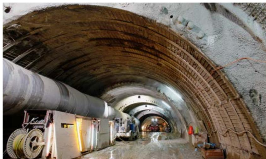
Mit Stahlbogen und Beton verstärkte Tunnelabschnitte, links das Rohr für die Frischluftzufuhr.
