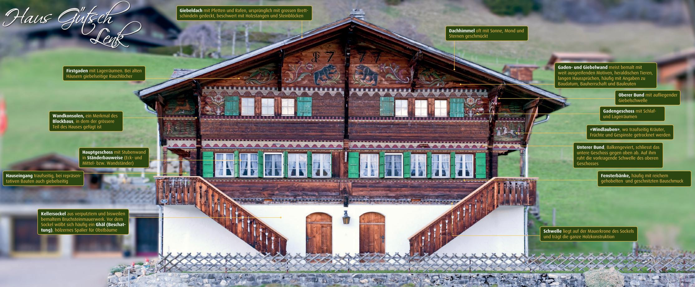
**1** Giebeldach mit Pletten und Rafen, ursprünglich mit grossen Brettschindeln gedeckt, beschwert mit Holzstangen und Steinblöcken
