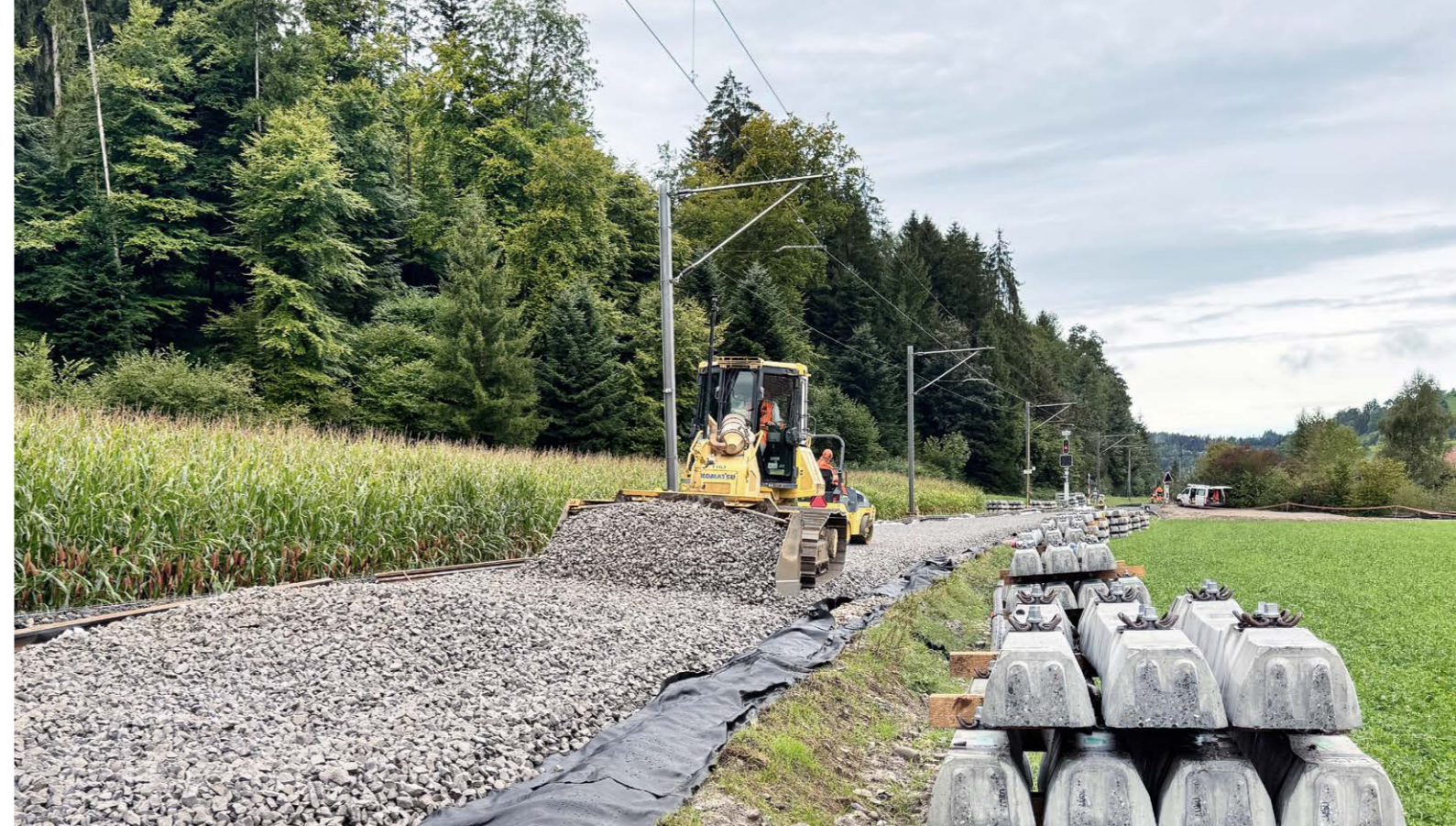
Recyclingschotter ist die Grundlage für die Stabilität der Gleise
