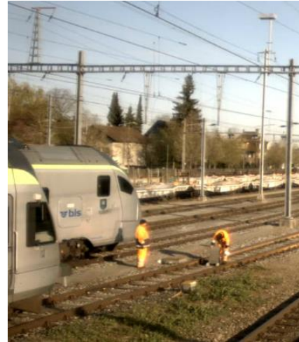
Abbildung 8: BLS-Weichen-Monteur bei Arbeiten am neu übernommenen Bahnhof Thun.
