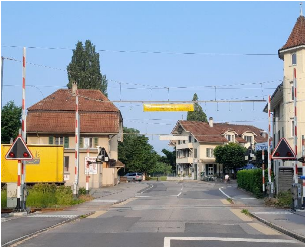
Abbildung 7: Bahnübergang Schwäbisstrasse nach Umbau auf BLS Material.
