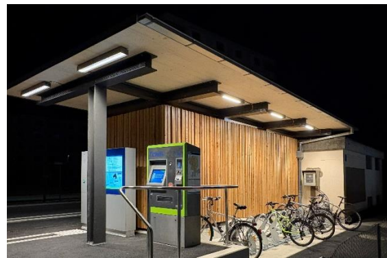
Abbildung 12: Nachtaufnahme der erneuerten Haltestelle Lädeli (bei Heimberg)
