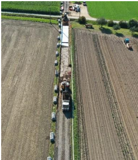
Abbildung 3 Umbau Zell-Gettnau mit Einsatz RC Schotter
