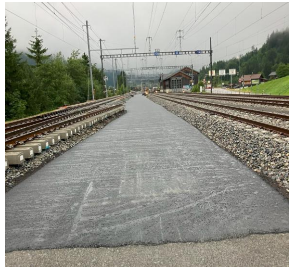
Abbildung 4 Umbau Kandersteg Gleis 12 mit Einbau Asphalt-Sperrschicht
