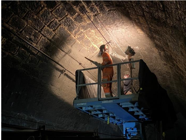
Abbildung 4 (Bild links) Sanierungsarbeiten im Grenchenbergtunnel (Erneuerung der Fugen)
