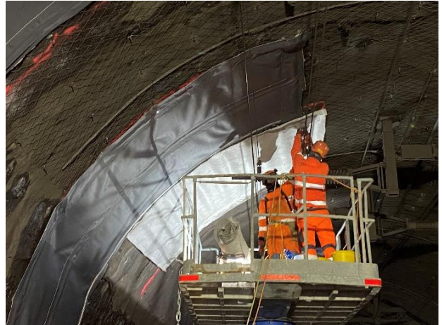
Abbildung 4 (Bild links) Sanierungsarbeiten im Grenchenbergtunnel (Erneuerung der Fugen)
