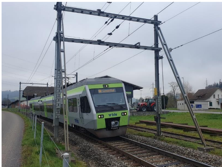
Abbildung 9 Streckentrennung in Lindenholz
