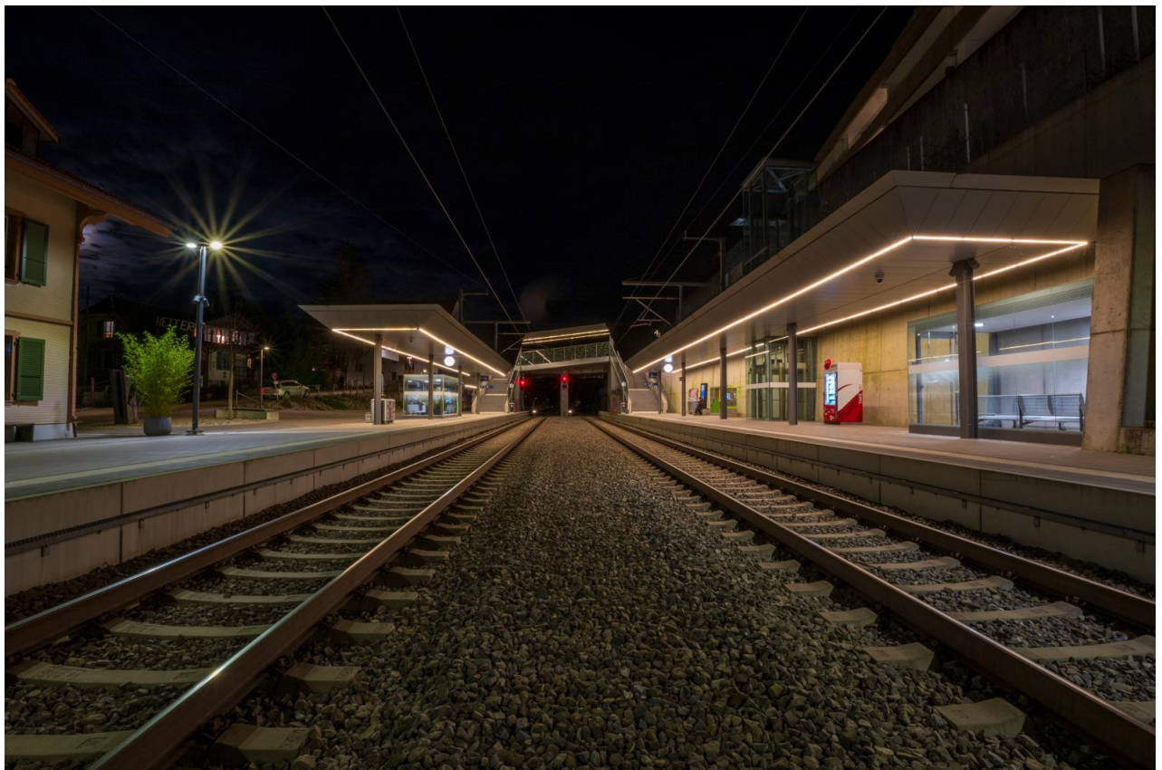
Abbildung 16 Nachtaufnahme bei der Inspektion der Haltestelle in Wabern
