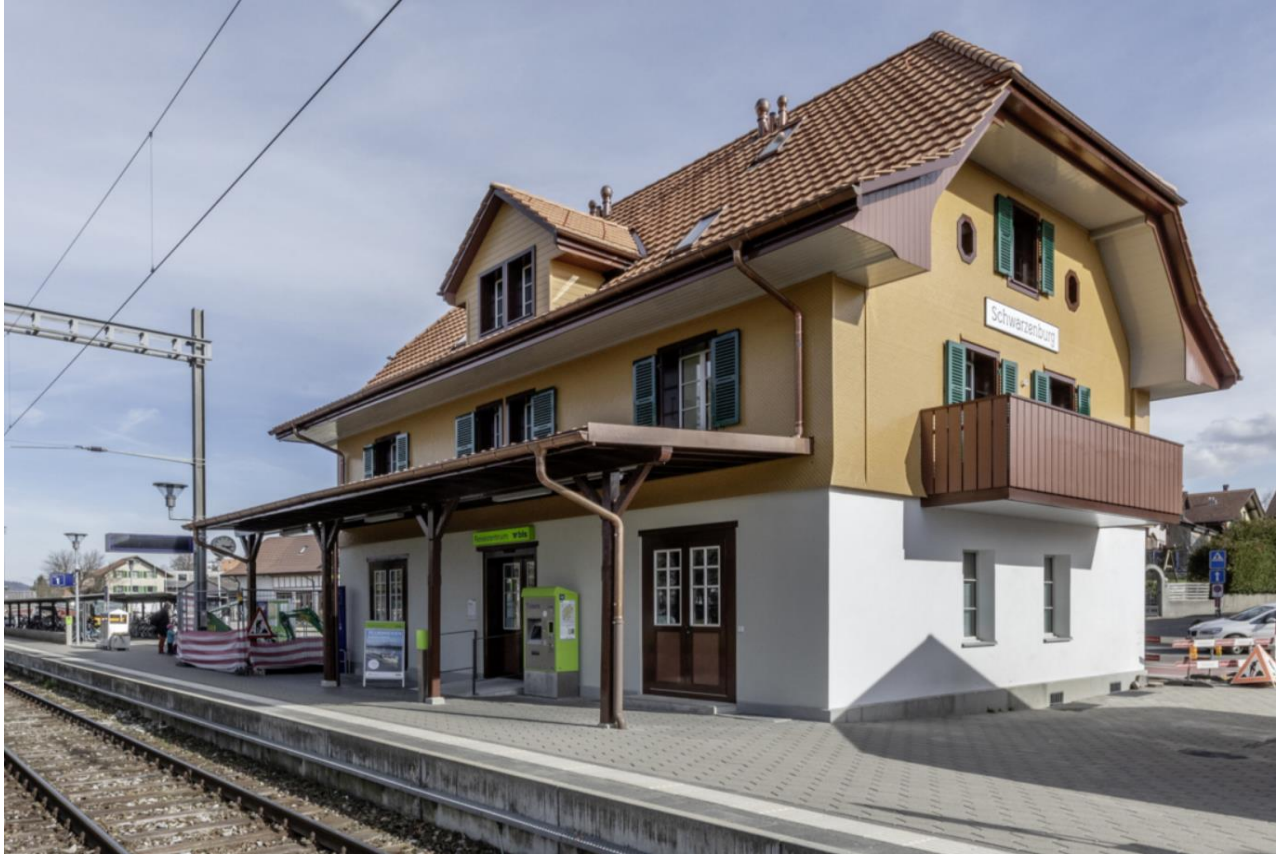
Abbildung 2 Saniertes Aufnahmegebäude in Schwarzenburg
