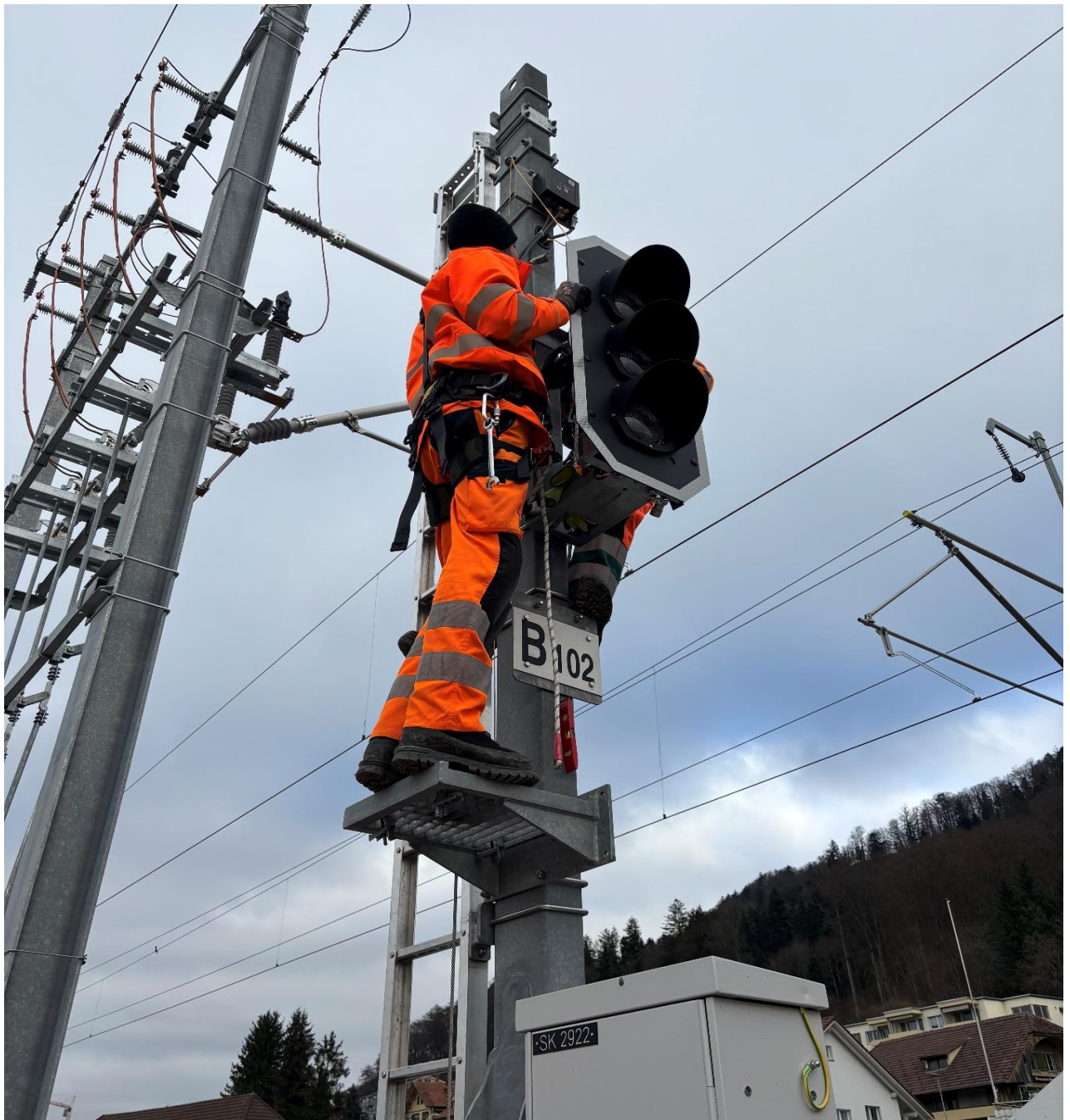
Abbildung 12 Montage Signal B102 beim Neubau Bahnhof Heimberg
