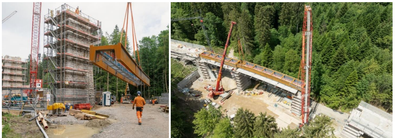
Abbildung 3 Erneuerung des Geissloch-Viaduktes nach Langendorf
