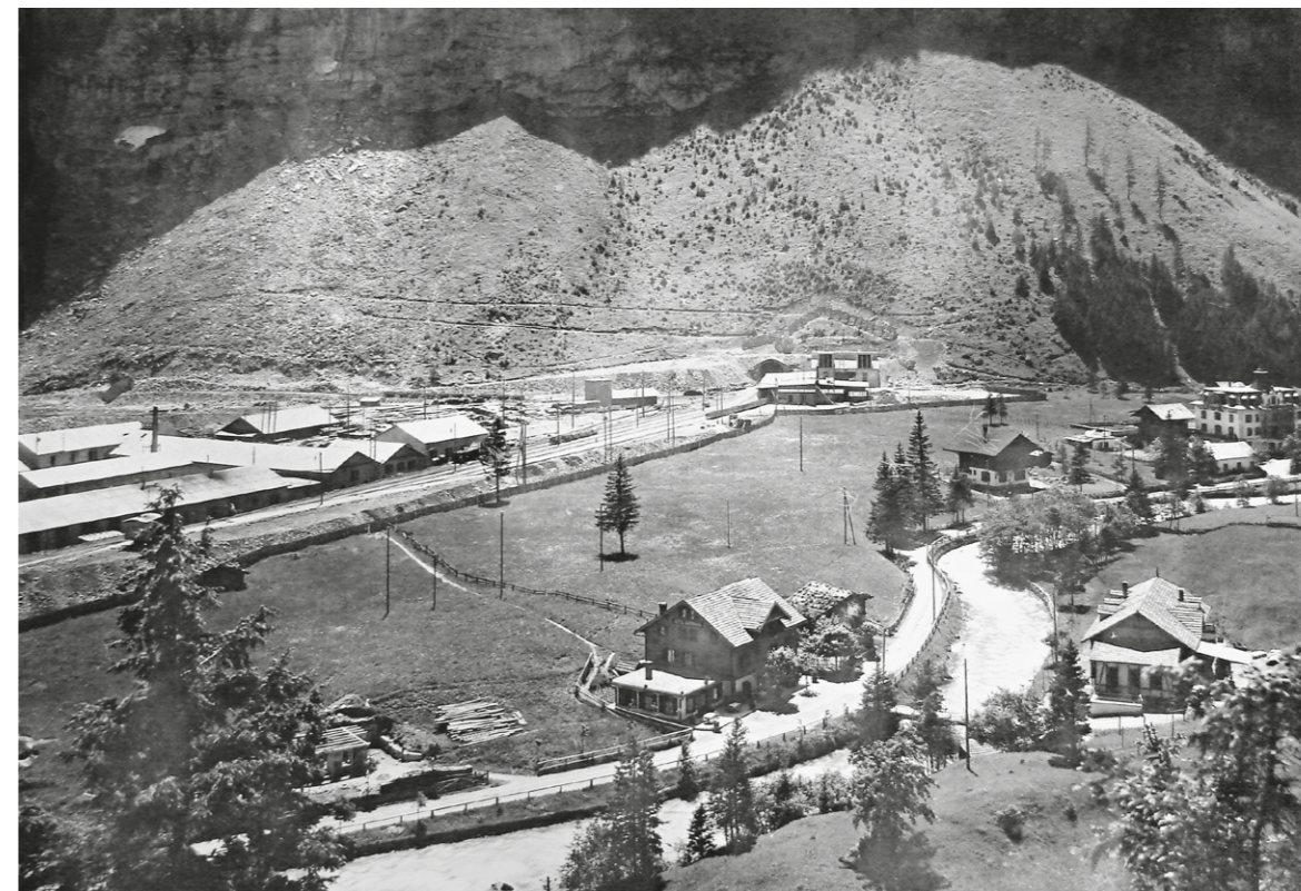
Nordportal des Scheiteltunnels in Kandersteg um 1911: Büros, Werkstätten, Wohnungen, Gaststätten und Läden für die Arbeiter bildeten ausserhalb des Ortes ein kleines Dorf (links im Bild).
