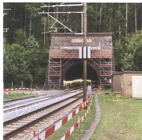
Tunnelnordportal Kandersteg (Eggenschwand)
