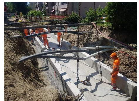
Einbau Bachdurchlass Lyssachsachen
