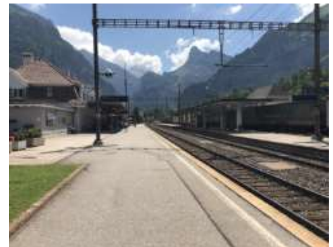
Die BLS modernisiert den Bahnhof Kandersteg.
