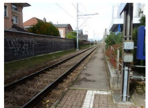
Haltestelle Schwäbis vor dem Umbau
