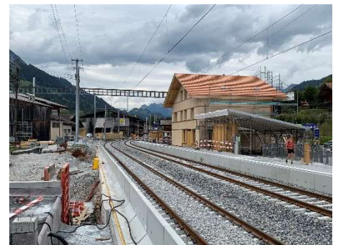
Saniertes Bahnhofsgebäude mit Perron 1
