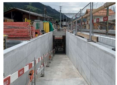
Neue Rampe zu Perron 2
