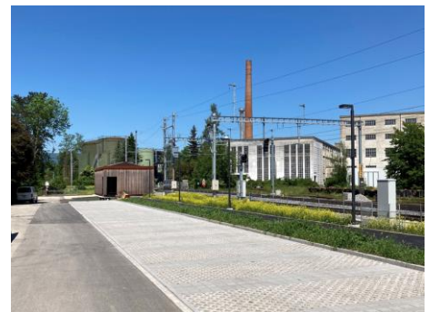
Fertige Parkplätze Bahnhof Biberist Ost
