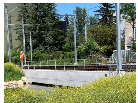
Neue Brücke Fabrikkanal Biberist Ost
