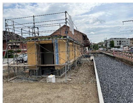
Rohbau Kiosk und Vorschotterung Gleis 1
