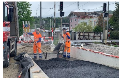
Belagsarbeiten Rampe zu Perron 2
