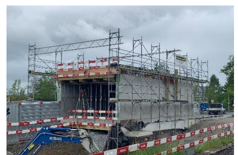
Vorfabrikation der Betonelemente für die Personenunterführung
