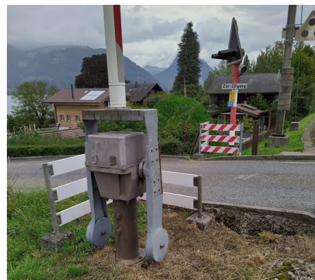
Signale und Barrieren werden bei verschiedenen Bahnübergängen ersetzt (hier Zihl-Zälgweg).
