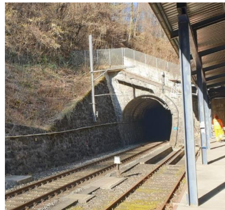
Bei den Portalen des Leissigbadtunnels werden Werkleitungen ersetzt und Teile des Mauerwerks saniert.
