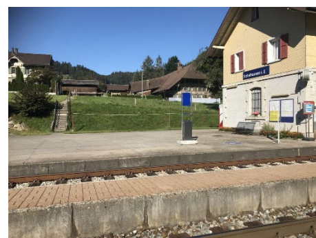
Das alte Bahnhofsgeläude wird abgerissen und eine neue, behindertengerechte Perronkante wird erstellt
